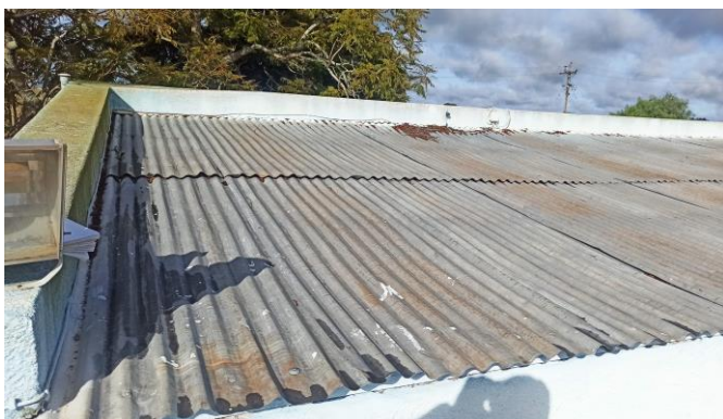
Pretiles a impermeabilizar y colocar babetas, sector con chapas deformadas a sustituir
