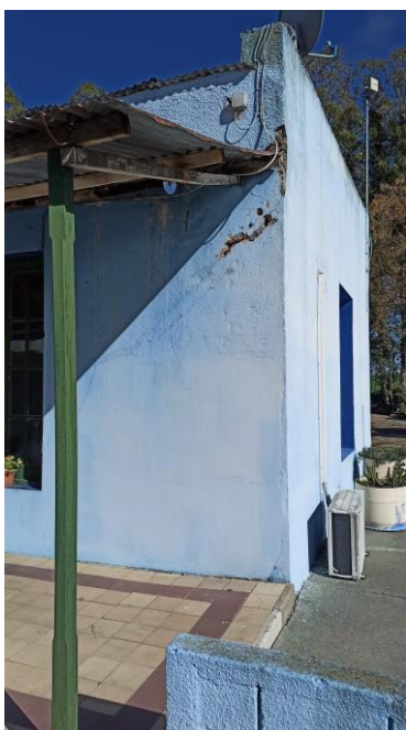
Pretiles a impermeabilizar y colocar babetas, sector con chapas deformadas a sustituir
